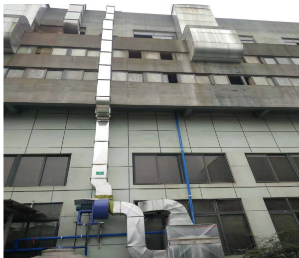
贴皮及热压废气处理装置(活性炭吸附塔)
